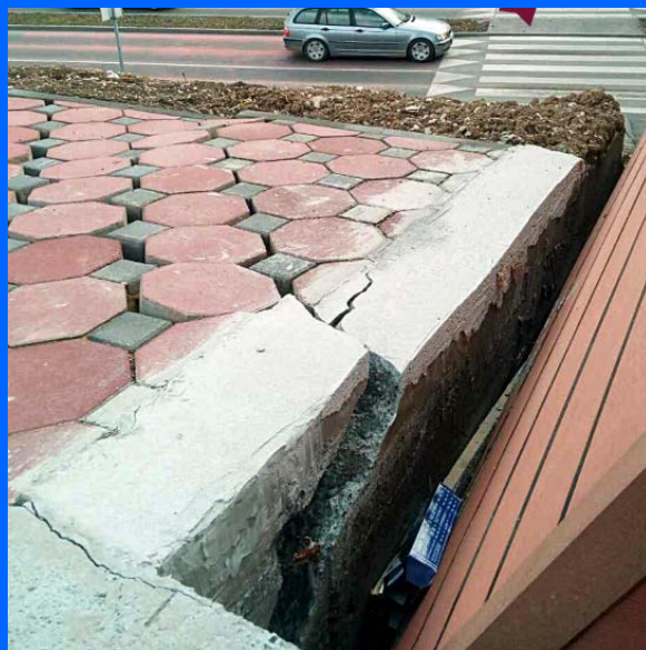
Posljedice crpljenja slane vode (slijeganje i deformacije terena)
